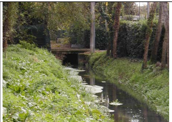
Figura 12. Punto di affaccio di un fossato coperto.
